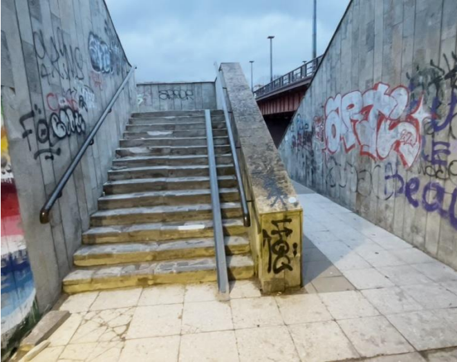
5. Laiptai iš požeminio tunelio link krantinės žiūrint Pietų kryptimi.
