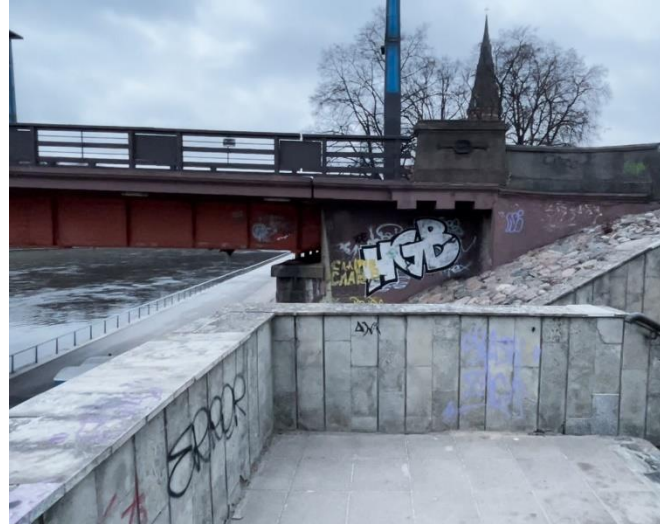
6. Sustojimo aikštelė laiptuose ties krantine žiūrint Vakarų kryptimi link Aleksoto tilto. Esamos betoninės plytelės su įtrūkimais, pažeistos, ištrupėjusios ir išlūžusios.
